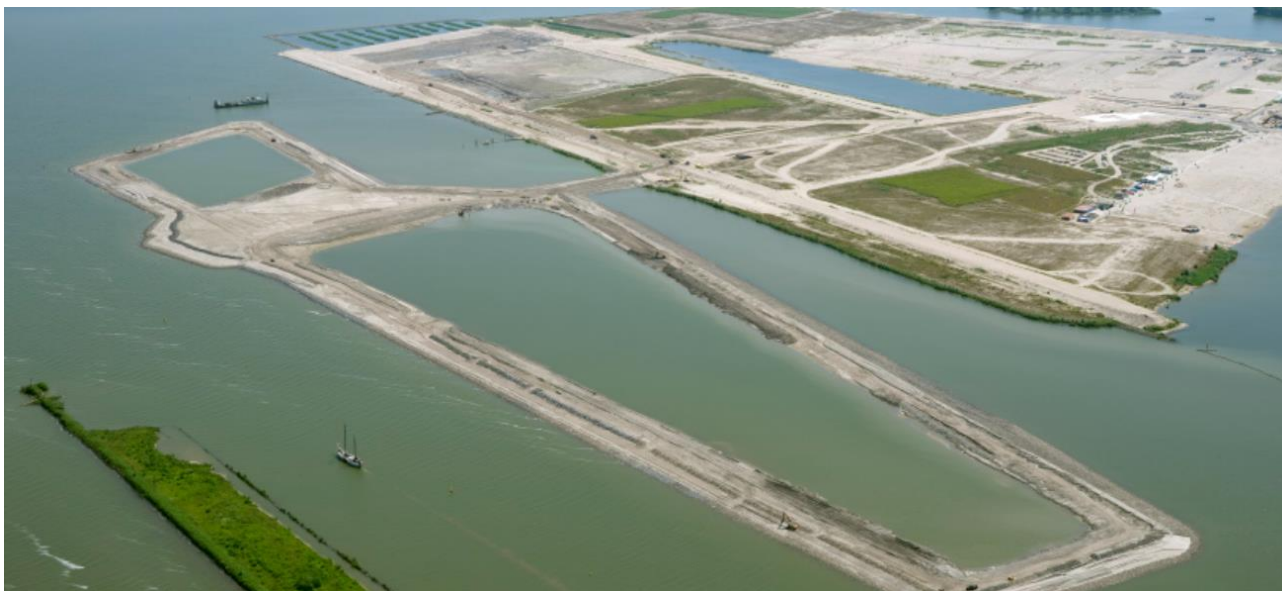
Figuur 3: Overzichtsfoto van de buitenring van Buiteneiland welke functioneert als een dijk. (Amsterdam, 2025)
